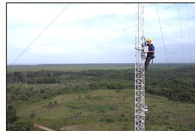
Installation d'enregistreurs à ultrasons pour étude l'activité en hauteur des chiroptères de Guyane
