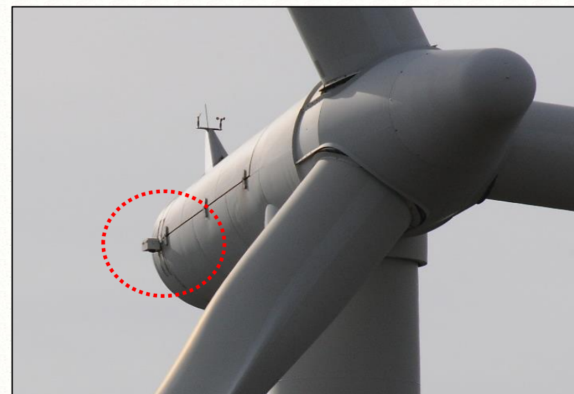
Cliché d'une adaptation de support de module Batcorder pour une éolienne métallique
